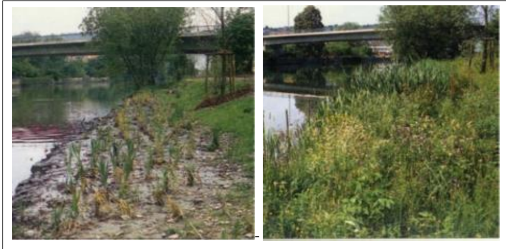
Gambar 2-5. (kiri) Pelindung Tebing Dengan Tanaman Pada saat Ditanam dan (kanan) Tanaman pada Usia Satu Tahun (Luderitz, 2012).
