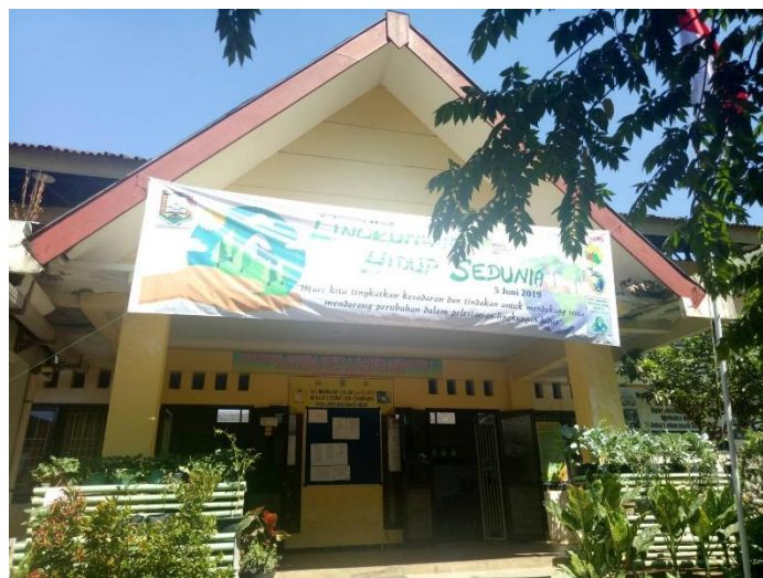
Gambar 4.1 Kantor Balai Desa Lerep Kabupaten Ungaran Barat
