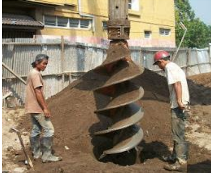
2.5. Pengeboran dengan Mata Bor Auger Telescopic Bor Pile (Dokumentasi Pribadi)
