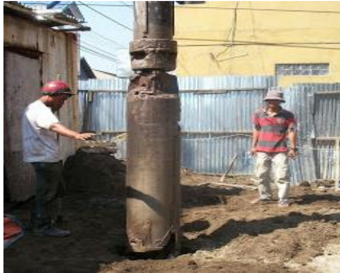
Gambar 2.7. Pembersihan Lubang Bor dengan Cleaning Bucket (Dokumentasi Pribadi)
