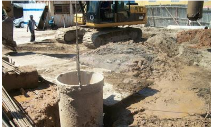
Gambar 2.4 Pemasangan Temporary Casing
