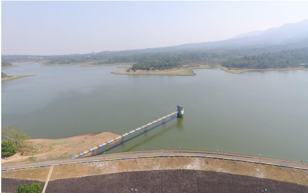
Gambar 1.1 Bendungan Gembong (Desember 2019)
