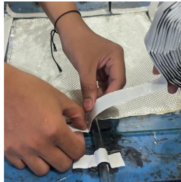
Gambar 3.40 Pemasangan sealant tape
