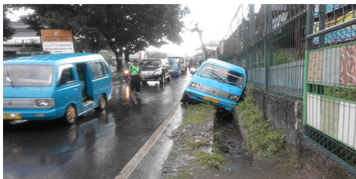
Gambar 1.4. Permasalahan Kecelakaan Lalu Lintas pada Drainase Jalan Raya (Bogordaily 2016)
