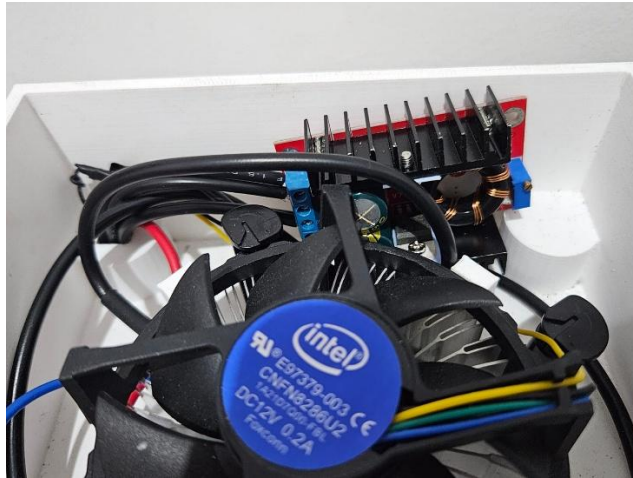
Gambar 4- 9 Tampilan boost converter setelah pemasangan
