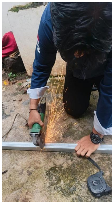
Gambar 4 . 5 Pemotongan Aluminium Hollow
