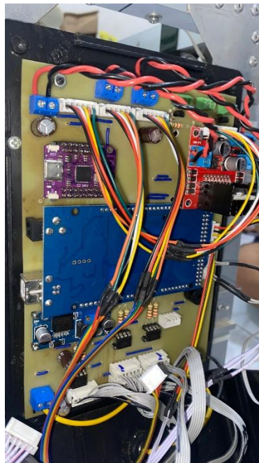
Gambar 4 . 4 Perakitan Komponen PCB
