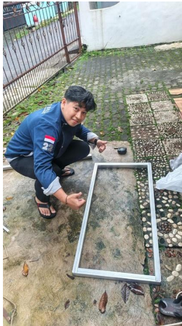
Gambar 4 . 6 Perakitan Rangka Atas Gantry Crane
