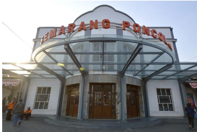
Gambar 3 Stasiun Kereta Api Semarang Poncol Sumber : PT. KAI
