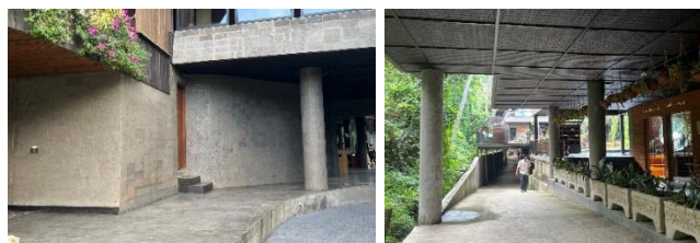
Gambar 2. 24 Pintu Linen Room dan Loading dock & Sirkulasi Mobil (Sumber: Dokumen Pribadi, 2026)
