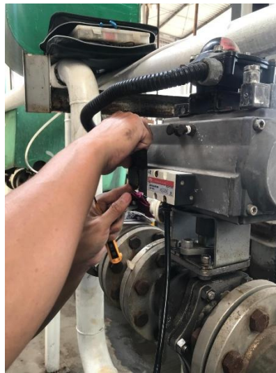
Gambar 4.15 Pemasangan Solenoid valve dan ACV
