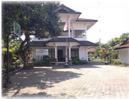
Gambar 2. 69 Gedung Utama BPRSW Yogyakarta
