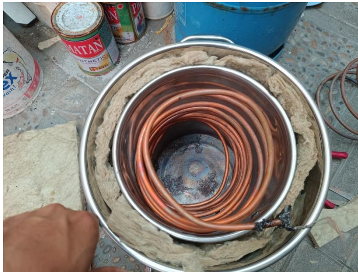
Gambar 4. 8 Pemasangan Pipa Tembaga
