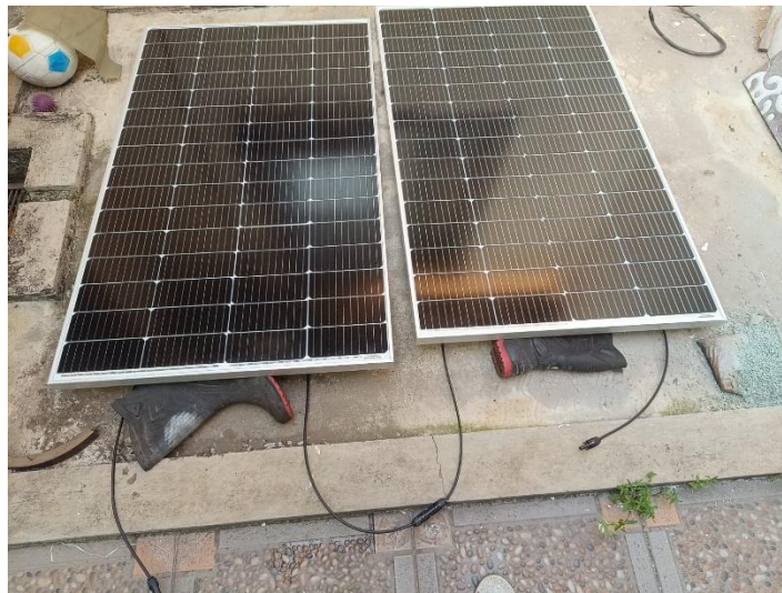
Gambar 4. 1 Pemasangan Panel Surya
