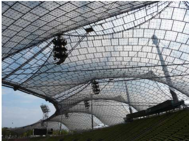
Gambar 5.2 Penerapan Material Atap Pada Munich Olympic Stadium
