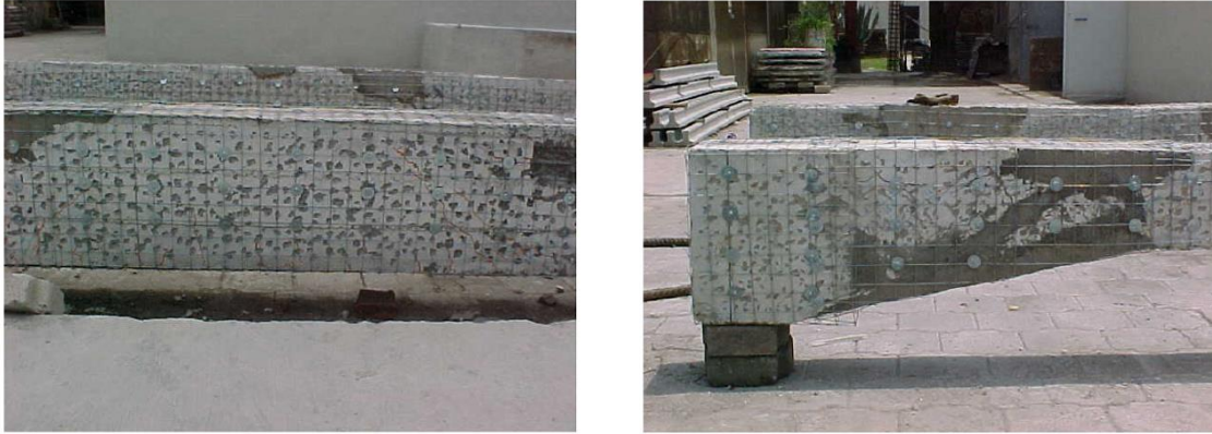
Gambar 2. 8. Tampilan fastened wired meshed yang diangkur sebelum jacketting dengan grouting
