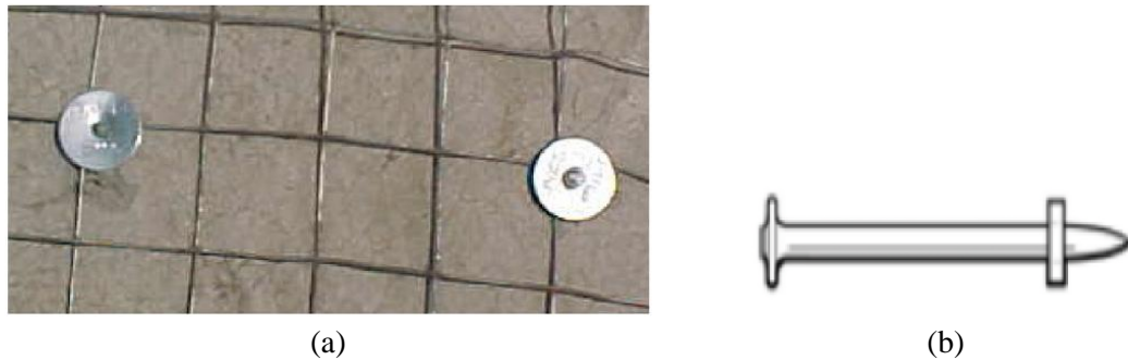
Gambar 2. 7. Prosedur pengencangan dari kawat las yang dilas ke muka balok (a) Detail pengencangan pada wired mesh 5 × 5 cm (b) Tipe ankur yang digunakan
