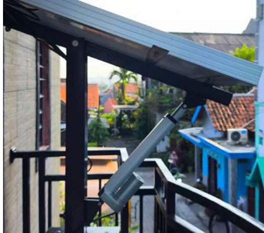
Gambar 4.5 Pemasangan Linear Actuator pada bracket di tiang panel
