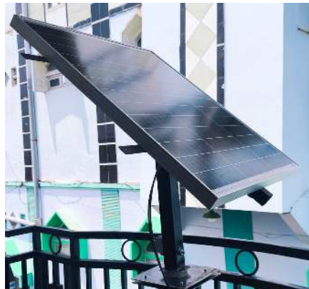
Gambar 4.1 Instalasi Panel Surya pada tiang
