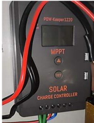
Gambar 4.2 Pemasangan SCC di dalam Box Panel
