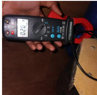
Gambar 4.16 Pengambilan Data Arus Pompa
