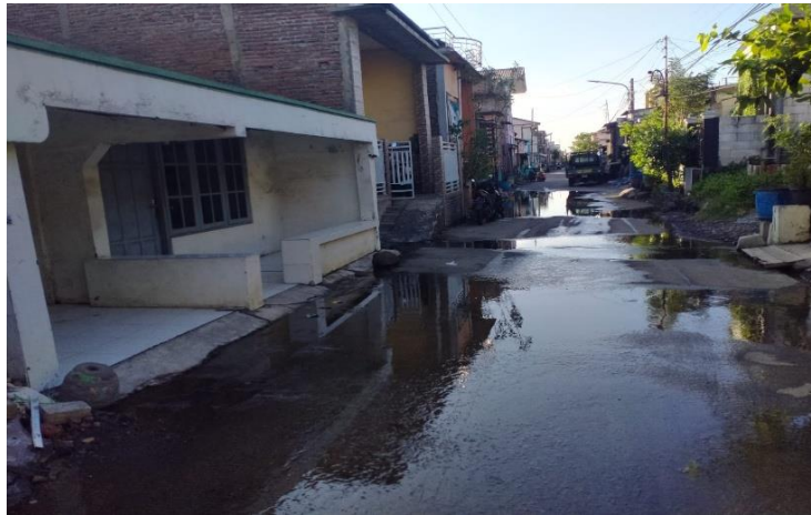
Gambar 1. 4 Rembesan Air Laut dari Sheet Pile Tahap I
