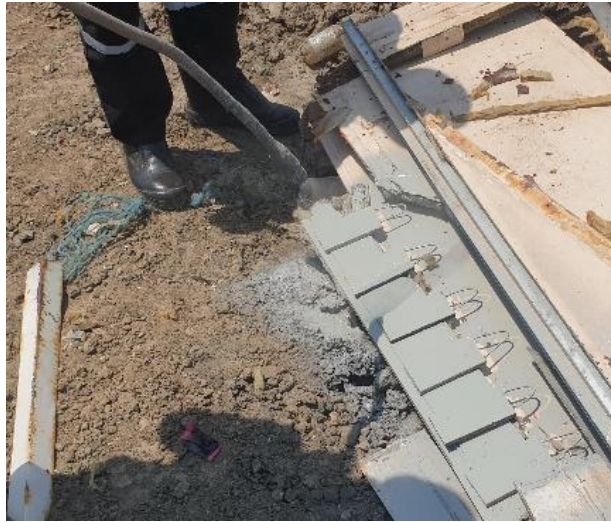
Gambar 4. 3 Proses Airless Spray Coating (Sumber: Dokumentasi Pribadi, 2026)
