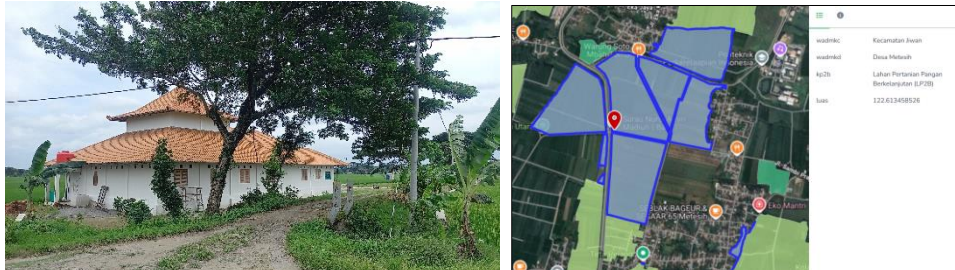
Gambar 1.2 Pembangunan Yayasan Tarekat Naqsyabandiyah Pada Kawasan LP2B di Desa Metesih, Kecamatan Jiwan, Kabupaten Madiun
