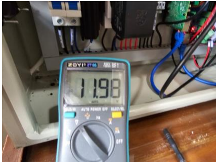
Gambar 4.37 Tegangan Motor Saat Aktif
