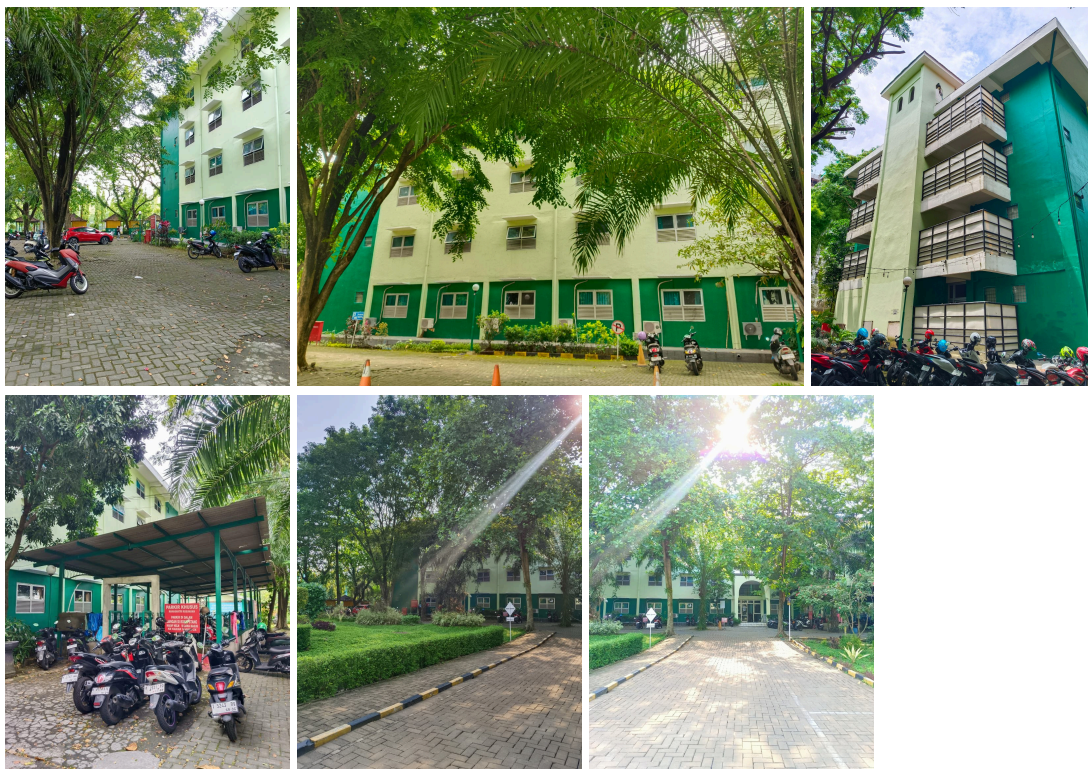
Gambar 3.7. Kondisi Lingkungan Sekitar Eksisting dan Tampak Eksisting Bangunan Sumber : Dokumentasi Pribadi, 2026
