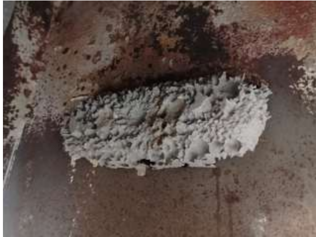
Gambar 4. 2 Zinc Anode Bolted pada Rudder Kapal
