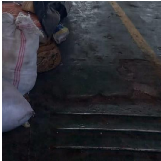
Lampiran 2 Pelat car deck yang telah di cor (Sumber: Penulis, 2024)
