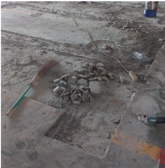
Lampiran 3 Pembongkaran Pelat car deck setelah di beton cor (Sumber: Penulis 2024)
