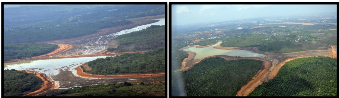
Gambar 2: Kondisi Eksisting Area Waduk Sei Pulai
