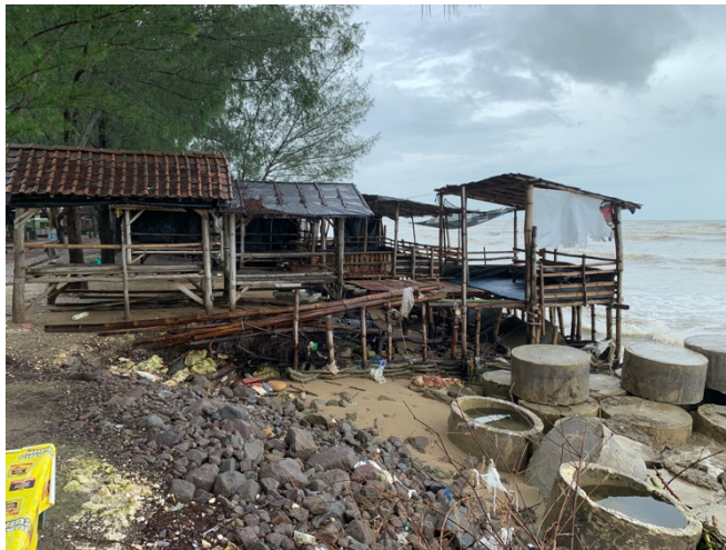
Gambar 2. 5 Kondisi Gazebo Rusak Akibat Semakin Majunya Garis Pantai di Caruban
