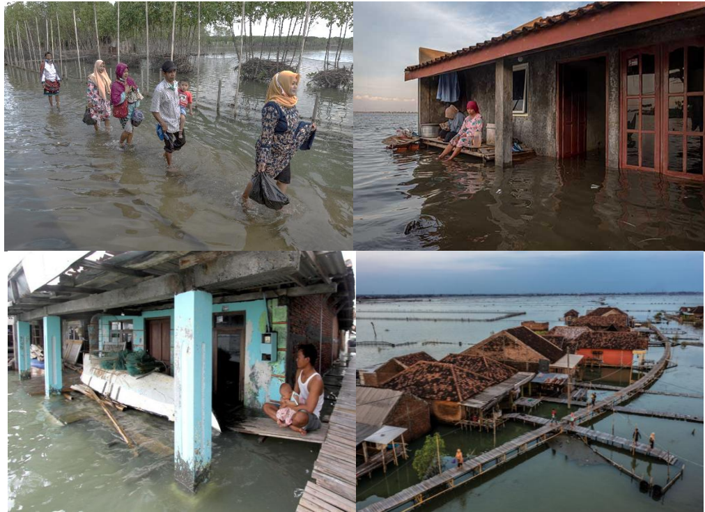
Gambar 1.3 Permukiman Terdampak Banjir Rob di Kecamatan Sayung Sumber: Antara Foto (2021-2023)
