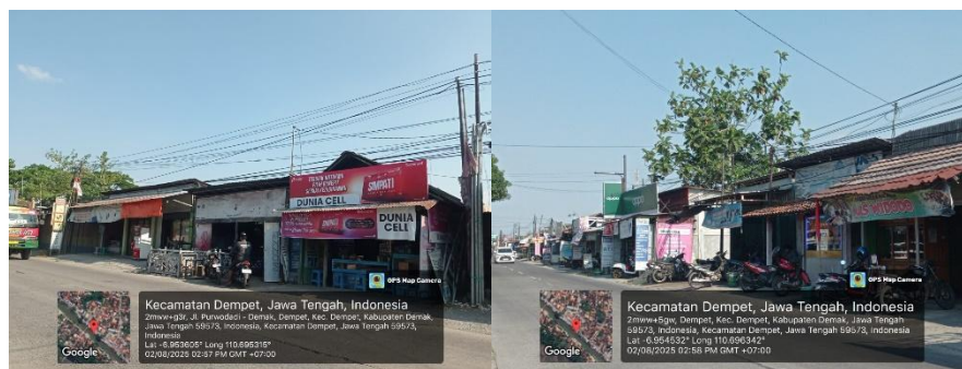
Sumber: Observasi Lapangan, 2025 Gambar 4.9 Potret Kondisi Pelanggaran Pemanfaatan Ruang Segmen 4 Dempet dan Kebonagung
