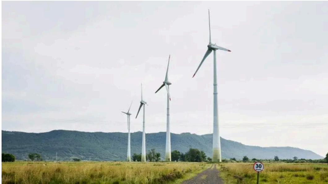
Gambar 2.5: Proyek Pembangkit Listrik Tenaga Angin De Arr
