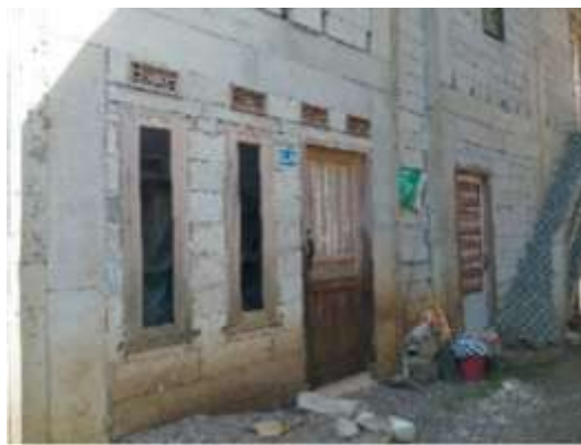
Gambar 5. 3 Kondisi Existing Kusen Kayu Basah Lembap
