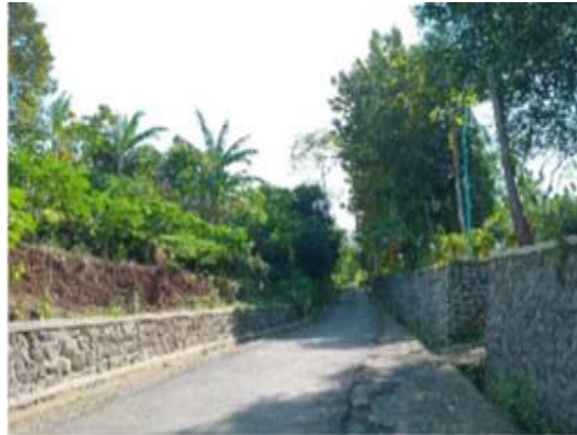
Gambar 4. 2 Batas Utara Unit Hunian Relokasi Bencana Menggunakan RUSPIN di Bumiayu, Brebes Sumber: Dokumentasi Penulis, 2025
