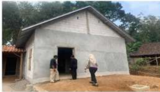
Gambar 2. 22 Rumah Panel RUSPIN di Karanganyar, Jawa Tengah Sumber: Rizky Aljunar Aqliansyah dkk., 2024
