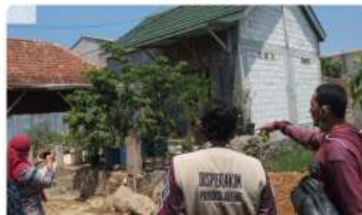
Gambar 2. 21 Rumah Panel RUSPIN di Pekalongan, Jawa Tengah
