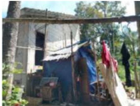
Gambar 1. 2 Ruang Tambahan di Luar Unit yang Menciptakan Kesan Kumuh
