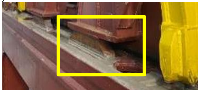
Gambar 2. 7 Bearing Pads (Sumber : Dokumentasi Pribadi)
