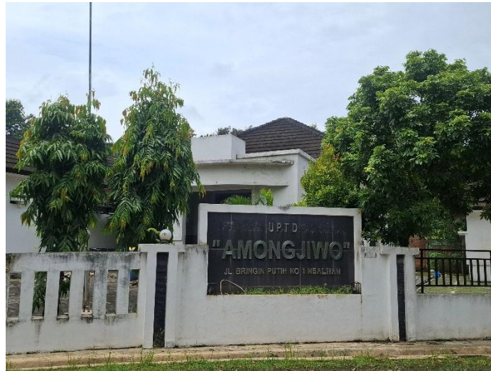
Gambar 2. 2 Bangunan UPTD Among Jiwo Kota Semarang
