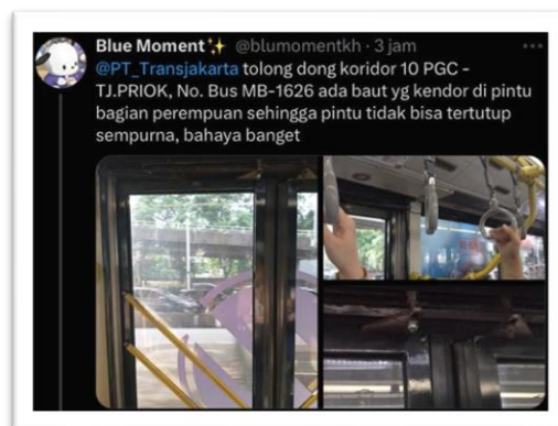
Gambar 1.7 Kerusakan pintu (Sumber: X/ @blumomentkh)
