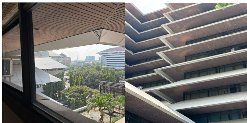
Gambar 2. 2 Gambar Kondisi Shading Sirip Gedung Setwilda
