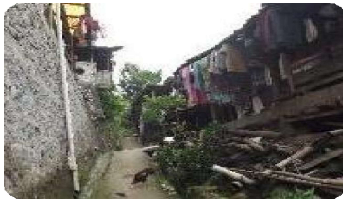
Gambar 2. 2 Kondisi Bangunan Tidak Layak Huni
