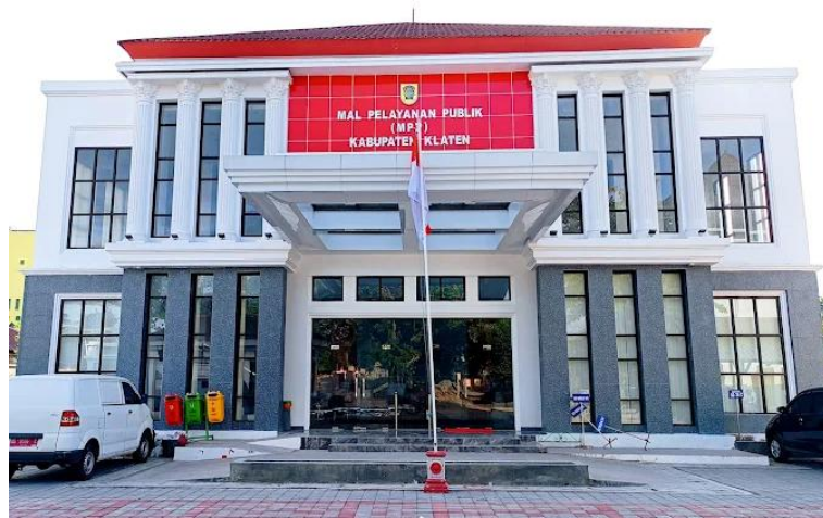
Gambar 2. 2 Gedung Mal Pelayanan Publik Kabupaten Klaten
