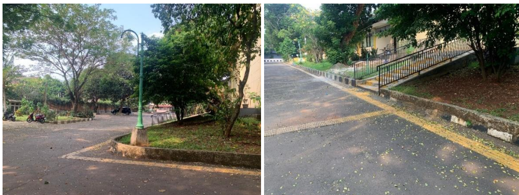
Gambar II-46 Guiding Blok pada Akses Outdoor SLB A di Jakarta (Sumber: Dokumentasi penulis, 2025)
