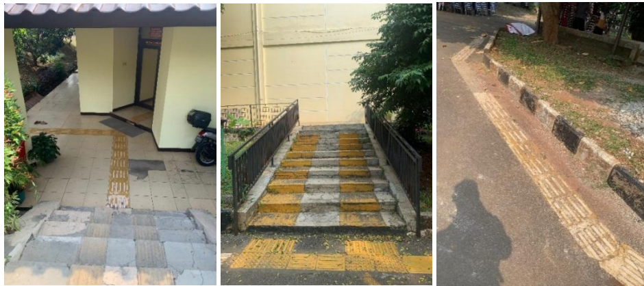
Gambar II-47 Guiding Blok pada Akses Outdoor SLB A di Jakarta (Sumber: Dokumentasi penulis, 2025)
