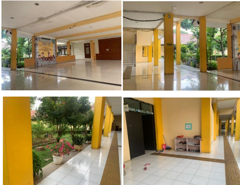
Gambar II-49 Kondisi Aksesibilitas pada Koridor dan Lobby Sekolah (Sumber: Dokumentasi penulis, 2025)
