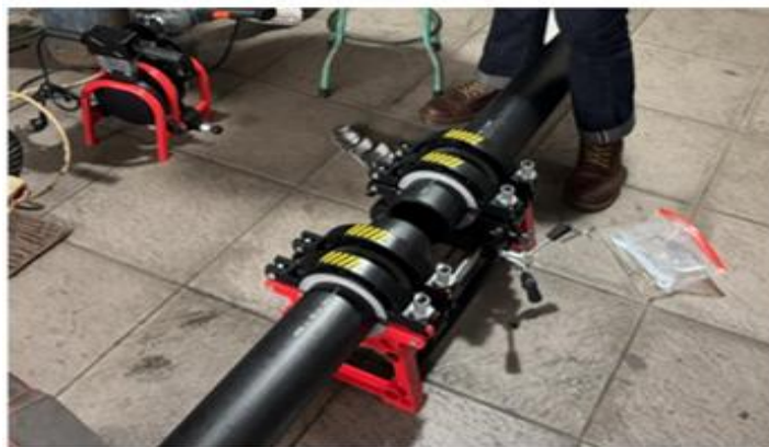
Gambar 4. 6 Proses pengelasan pipa HDPE untuk spesimen pengujian hidrostatik
