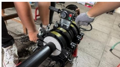
Gambar 4. 2 Pengelasan pipa HDPE untuk spesimen pengujian tarik
