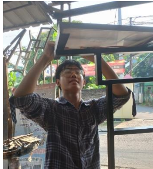
Gambar 4-2 Pemasangan Panel Surya Pada Rangka
