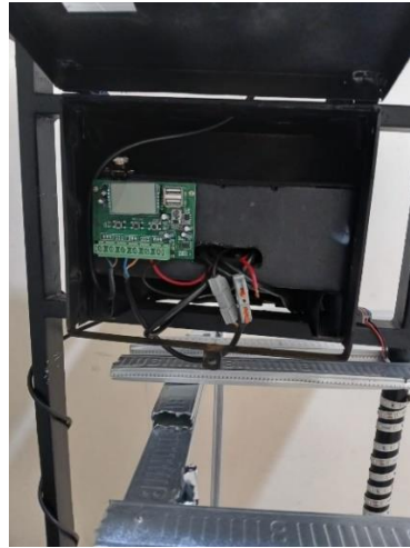
Gambar 4-4 Pemasangan Box Komponen Pada Rangka
