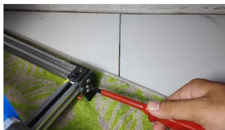
Gambar 4. 17 Pemasangan Limit Switch (Sumber : Dokumen Pribadi, 2025)
