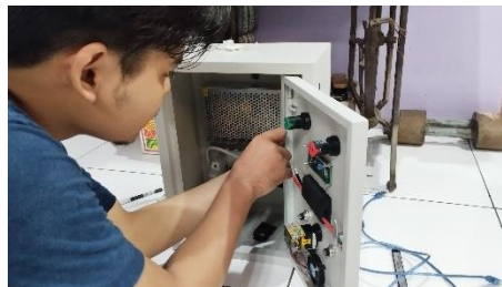
Gambar 4. 23 Pemasangan Komponen pada Box Panel (Sumber : Dokumen Pribadi, 2025)
