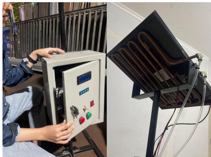
Gambar 4. 9 Pemasangan Panel Surya dan Panel Box
