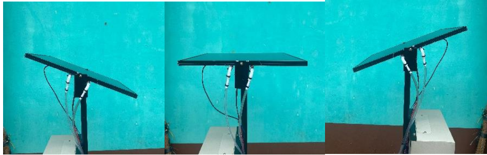
Gambar 4. 8 Modifikasi Pemasangan Panel Surya
