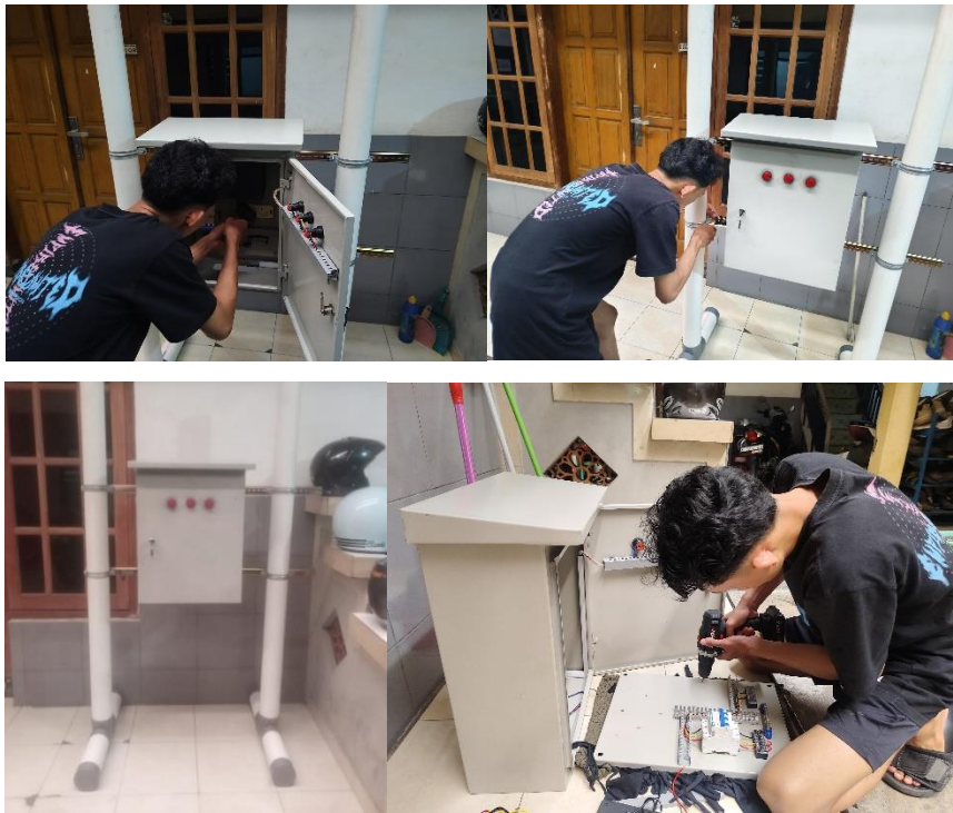
Gambar 4. 3 Proses Pembuatan Diorama Gardu Portal
