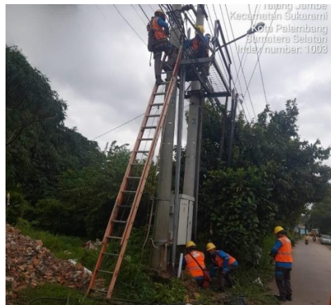
Gambar 2. 3 Proses Perbaikan Kabel Akibat Pencurian
