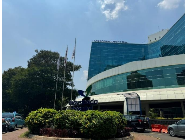
Gambar 2. 3 Mayapada Hospital Lebak Bulus Sumber : Survey Pribadi
