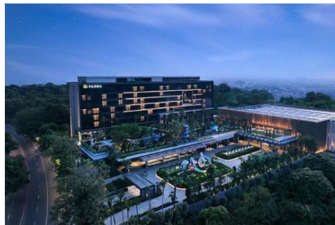
Gambar 2.4 Tampilan Bangunan Padma Hotel Semarang (Sumber : tripadvisor.co.id, 2024)
