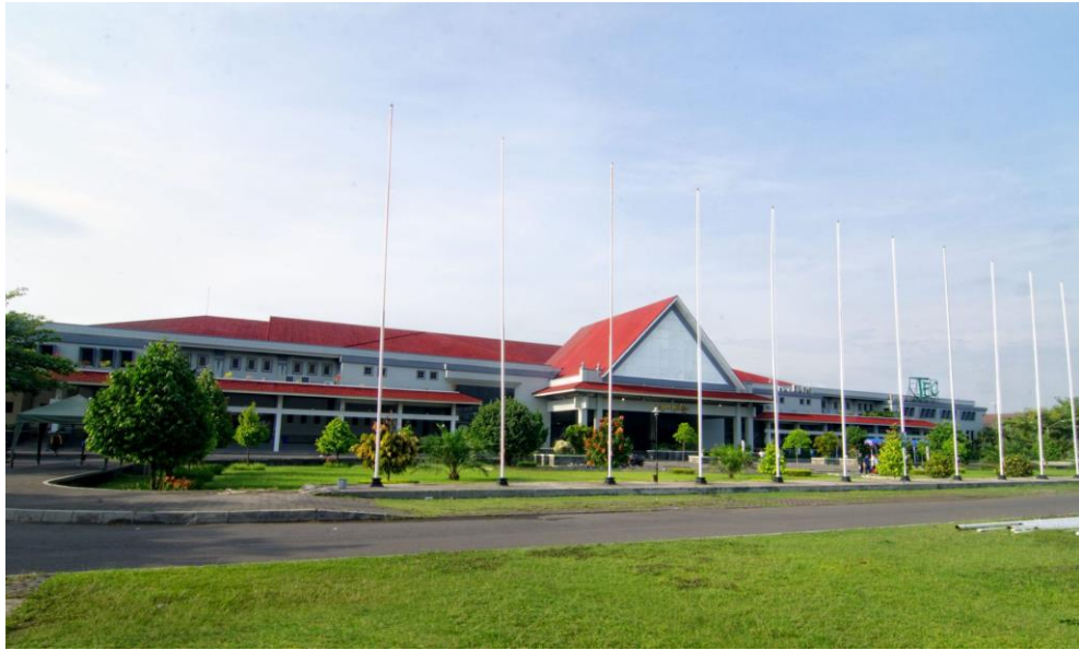
Gambar 2. 4 Tampak Depan JEC
