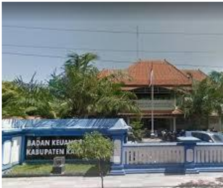
Gambar 2.1 Gedung BKD Kabupaten Karanganyar
